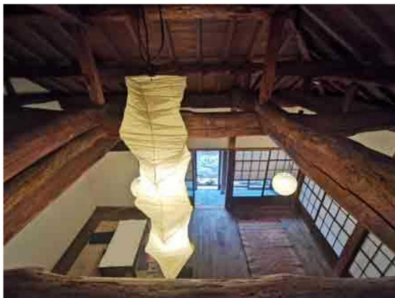
2Fから見る 居間小屋組
