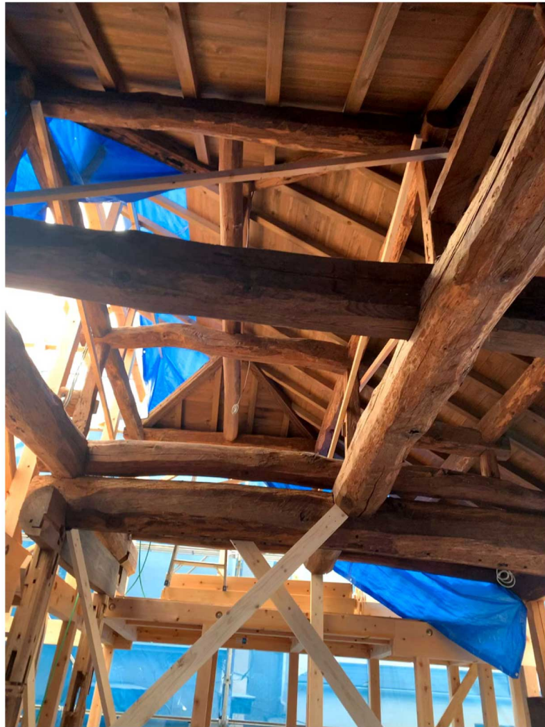
組みあがった古民家の 小屋組。
